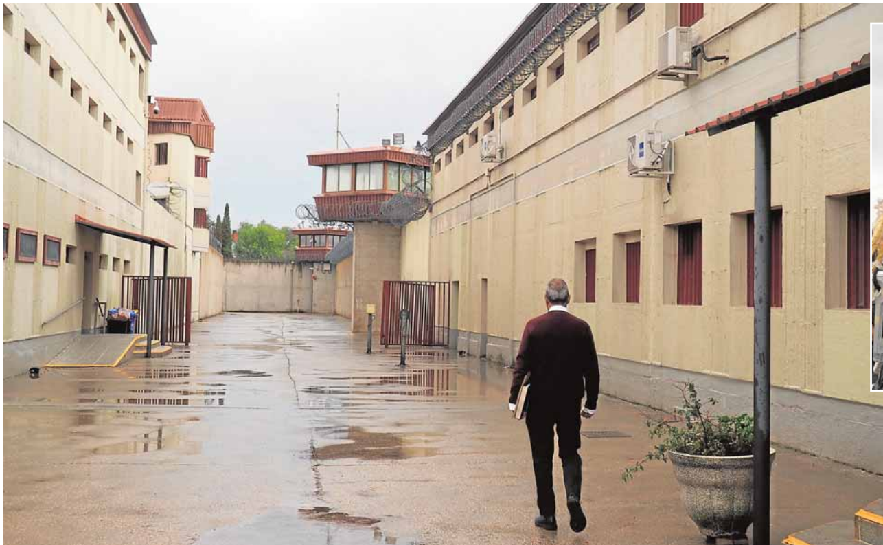
Foso del centro penitenciario de Valladolid // C. R. M.
