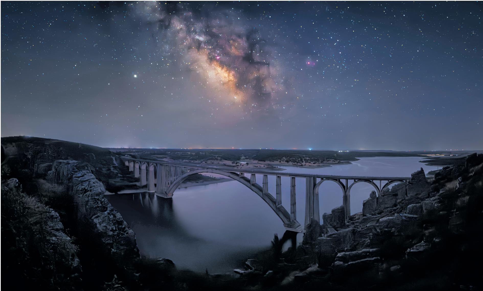
Cielos del viaducto de Martín Gil, sobre el embalse de Ricobayo, en Zamora // A. ALONSO
